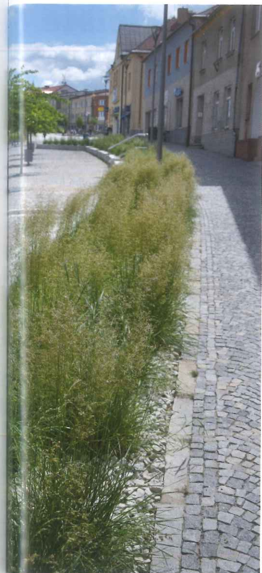
Štérkový záhon – propustný povrch pro dešťovou vodu na náměstí ve Žďáře nad Sázavou
