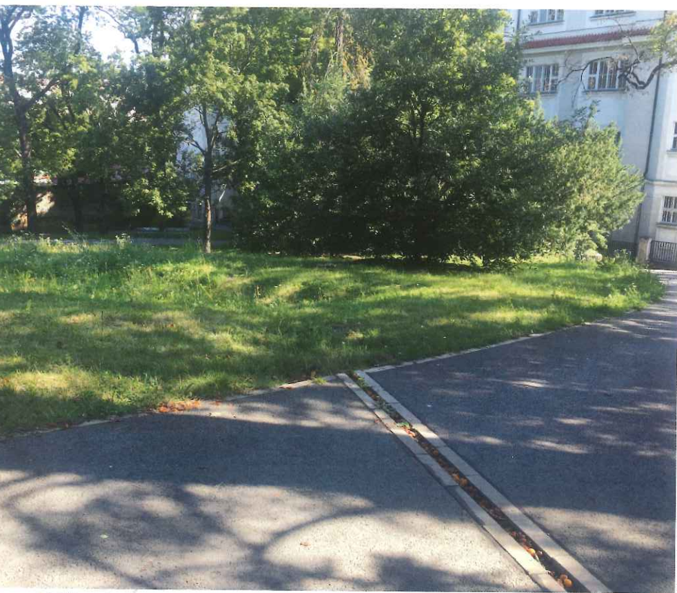
Průleh v parku Thomayerovy sady v Praze – ukázka svedení dešťové vody ze zpevněných povrchů
